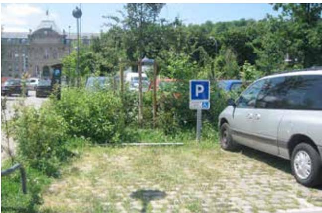
Stationnement de véhicules perméable
