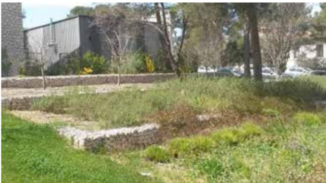
Type de gabions permettant de traiter les différences de dénivelé
