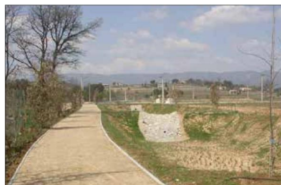
Cheminement doux et bassin de rétention Parc du Revol à la Tour d'Aigues Le bassin met à distance les limites des lots d'une promenade qui traverse et relie des habitations à la campagne environnante. La ZAE maintient ainsi des usages pour tous.
