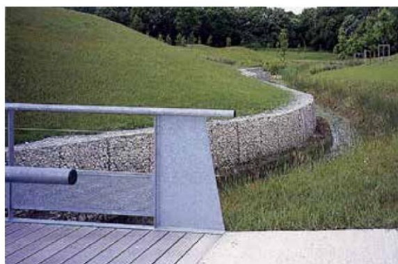
Le gabion particulièrement bien adapté au espaces humides Un mur gabion en accompagnement d'une noue ou bassin de rétention participe à l'enrichissement de la biodiversité et véhicule une image de qualité environnementale.
