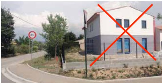
Selon l'implantation, la façade principale devient le pignon ce qui génère une incohérence architecturale majeure pour l'identité du site
