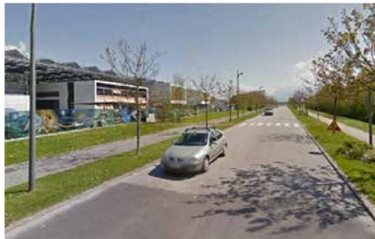
Alignement des façades le long du CR4 et recherche d'un rythme entre les vides et les pleins, d'une ligne des toitures sans rupture...
